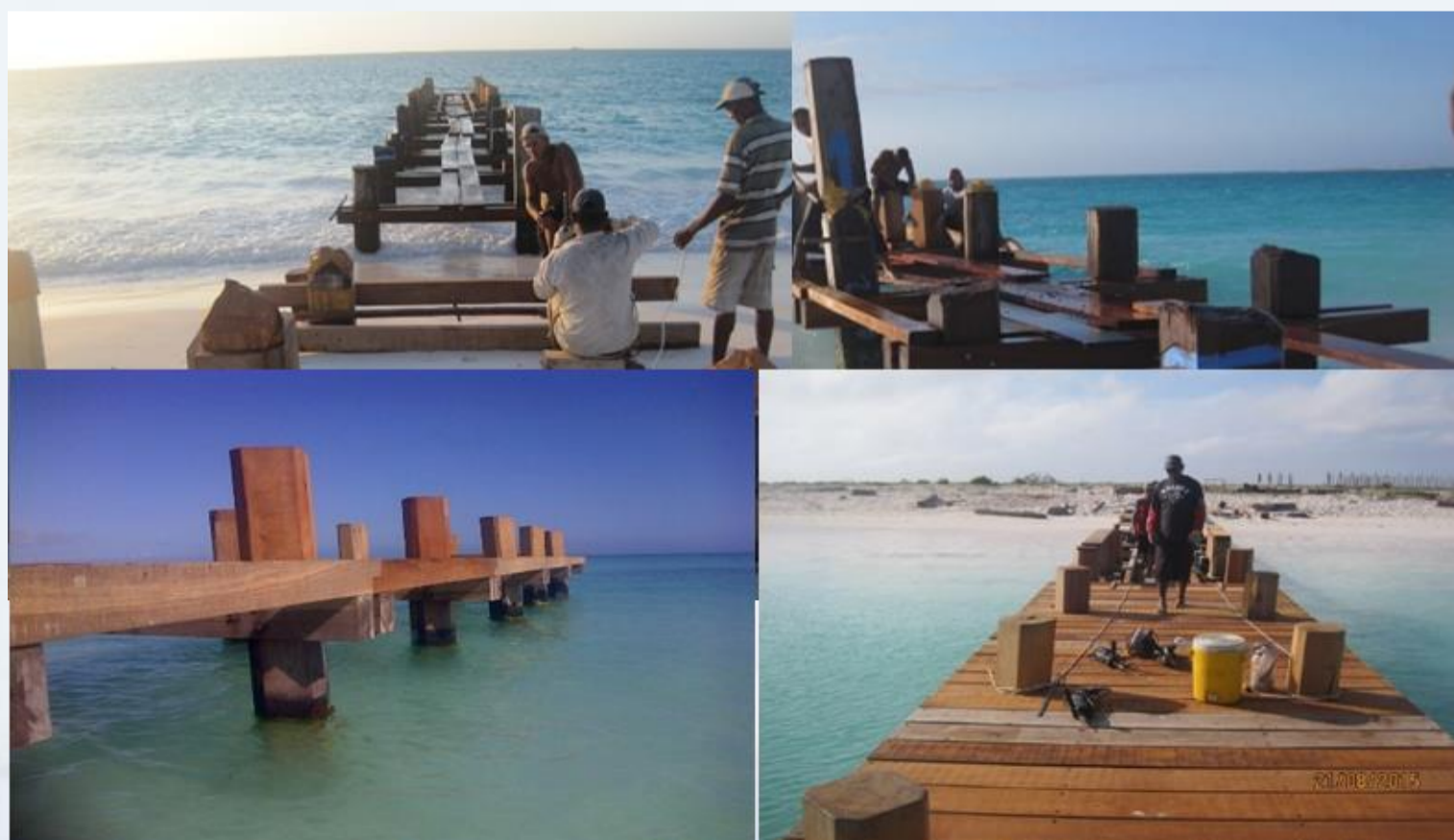
Detalles de la obra
